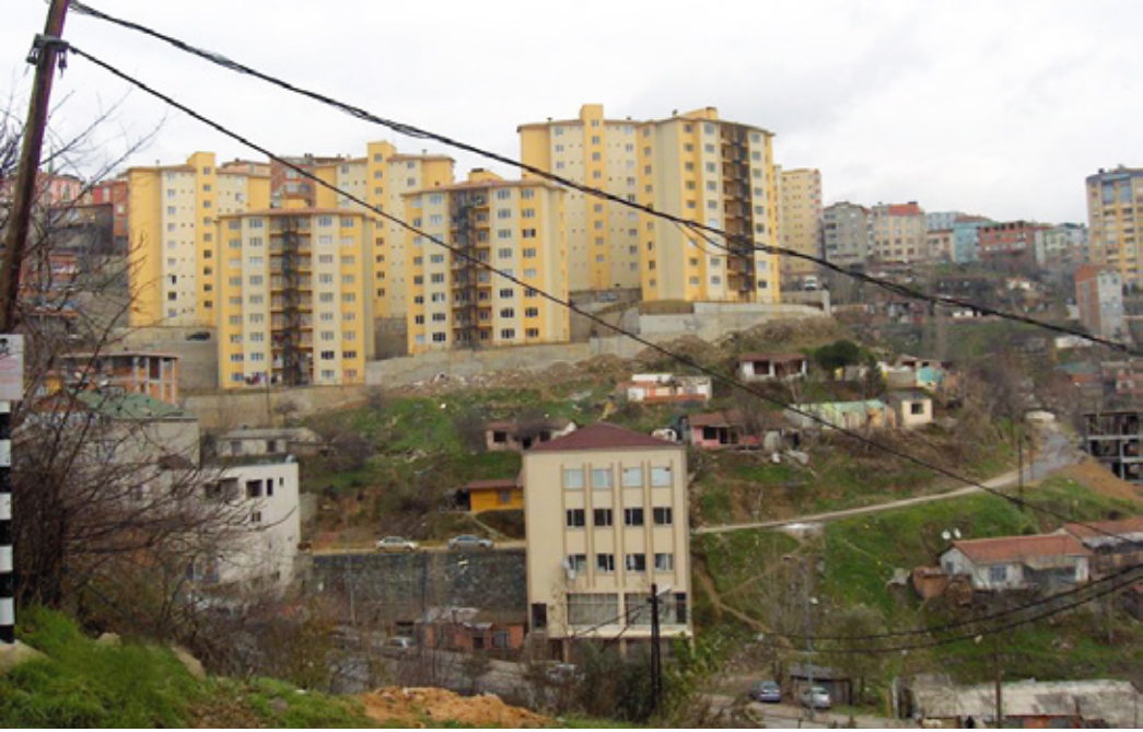
Kağıthane Mesken Konutları, Kasım 2014.
